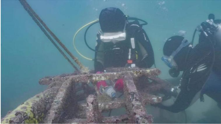
图：温度记录仪的安装
