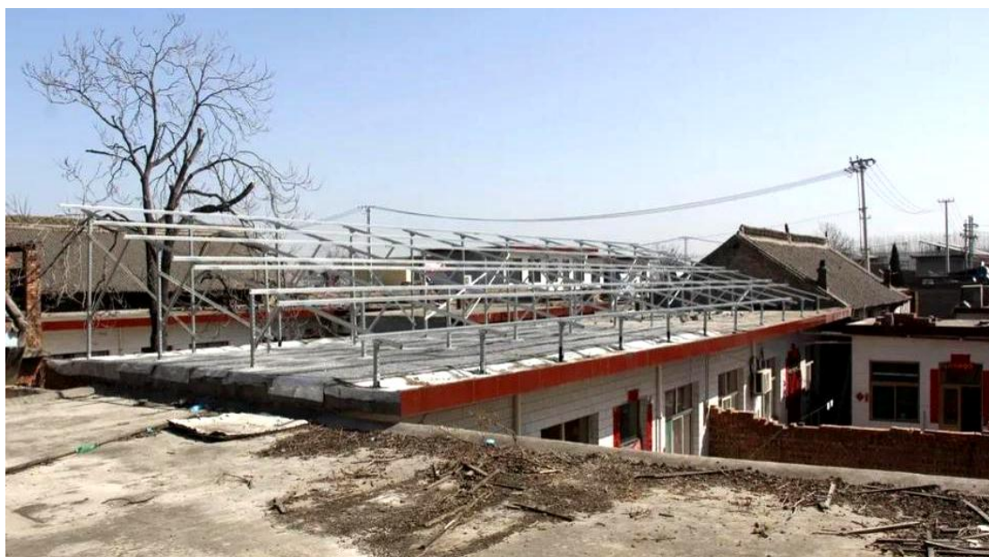
图 24 将要安装的光伏发电板的支架
