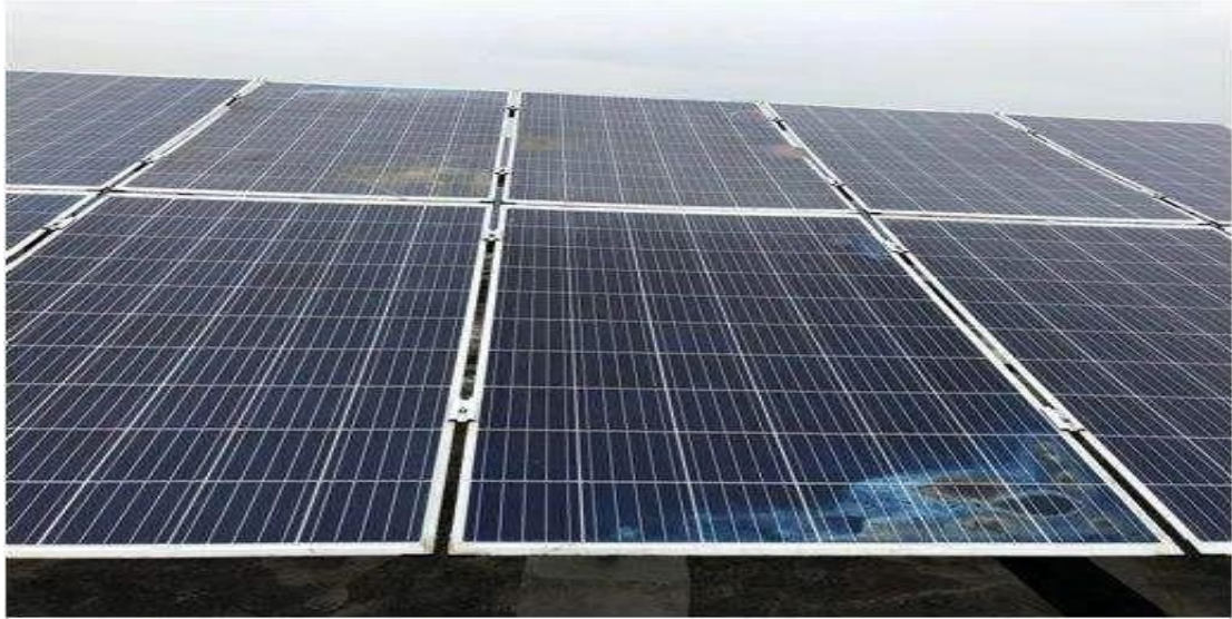
图 26 形成“热斑效应”的光伏板
