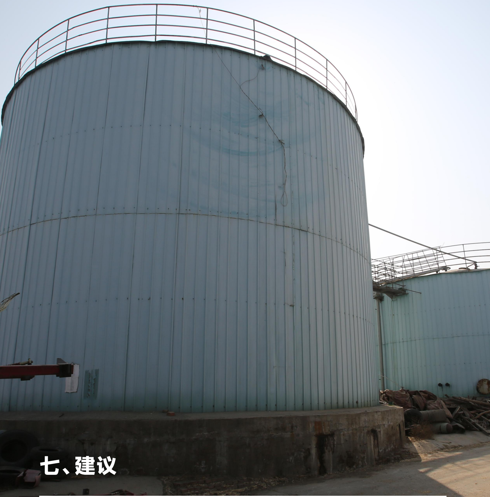
图 安阳市殷都区北盟办一家养牛厂的沼气罐
