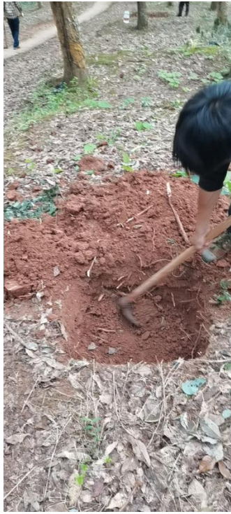
施工方在挖坑
