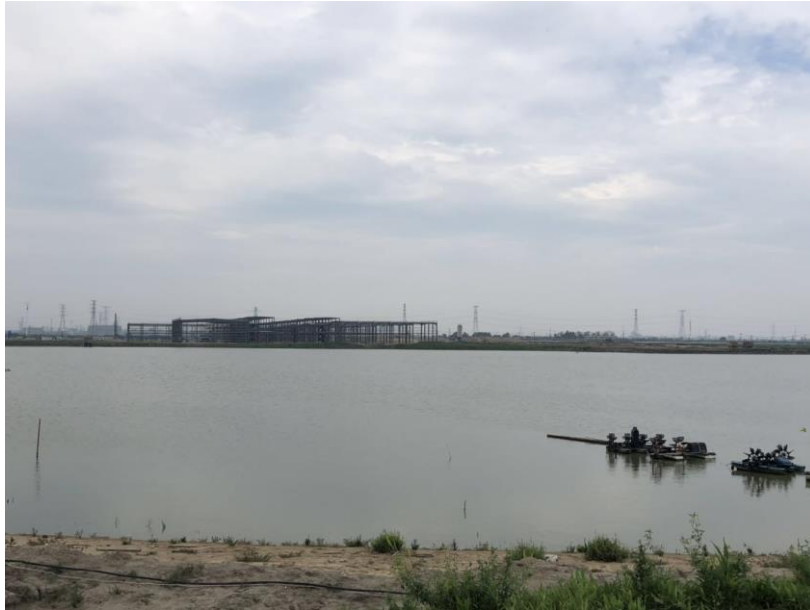
兴化湾西线地块（可以看到远处在建的工业园区）
