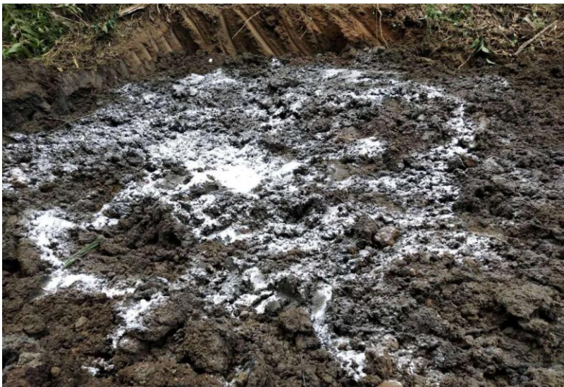
矿物盐和泥土搅拌之后回填
