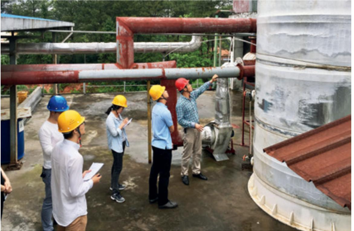
图为绿家园到企业工厂审核排污情况，正在查看碱液喷淋塔情况。碱液喷淋塔是处理盐酸、硫酸、硝酸等工艺中产生的酸性废气不可缺少的设备。摄影/陈征宇
